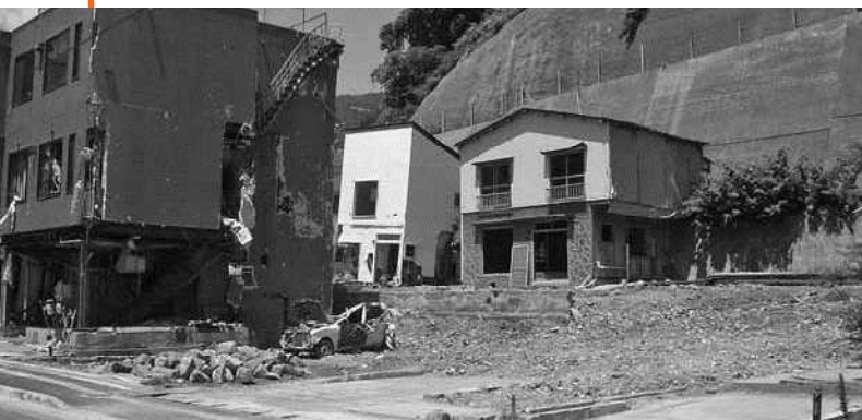
東日本大震災における建物の被害 (左は倒壊を免れたコンクリート造建物、右の空き地は流失した木造建物の跡)
