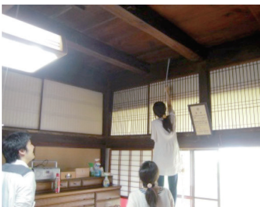
古民家の構造調査
