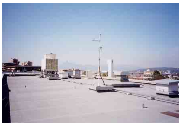
写真 環境共生学部旧棟屋上全景
