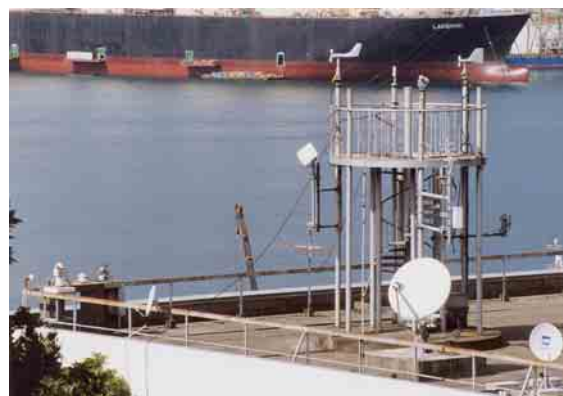
写真 長崎海洋気象台の測風塔
