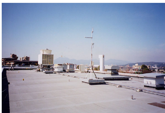
写真 環境共生学部旧棟屋上全景
