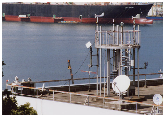
写真 長崎海洋気象台の測風塔
