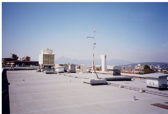
写真 環境共生学部旧棟屋上全景
