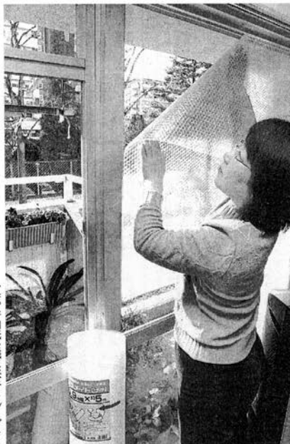
断熱シートをガラス窓に貼ることで結露が防止できる
