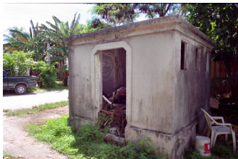
写真1 RC造の便所
