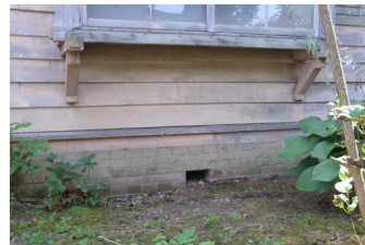
写真3 旧北海道製糖本社社宅の床下換気口
